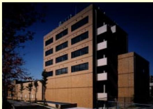
ナノデバイス・システム研究センターの新棟（東棟）が1998年10月末に完成しました。5階建、クラス10（0.1  $\mu\text{m}$ 以上の粒径の塵埃の密度が1立方フィートの大気中に10個以下）のスーパークリーンルーム250 $\text{m}^2$ を含む延面積2780 $\text{m}^2$ の建物です。1階がクリーンルーム、2～5階が実験室・コンピュータ室・研究室・教官室・会議室などです。クリーンルームは、塵埃だけでなく、ケミカルフィルターを用いて酸性およびアルカリ性ガスを除去した超清浄空間を創り出し、汚染にきわめて敏感な半導体表面の研究ができるようになっています。
